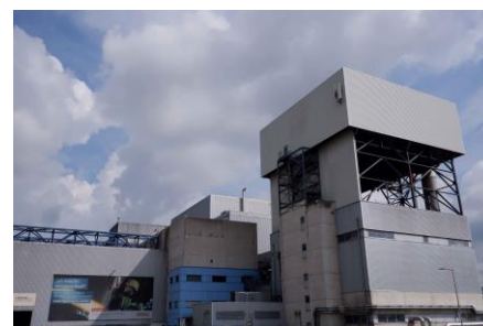
Verbrennungsanlage in Wels
