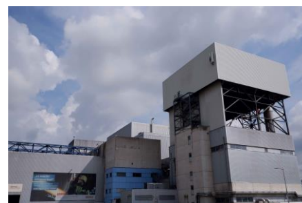
Verbrennungsanlage in Wels
