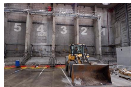
Anlieferung bei den Bunkern
