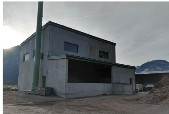
Das neue Heizwerk in Asten
