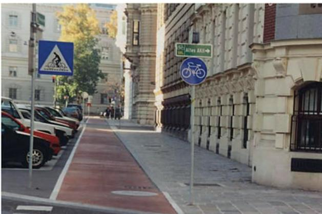
Abbildung 85: Straßenbegleitender Radweg mit farblicher Trennung und Schrägbord
