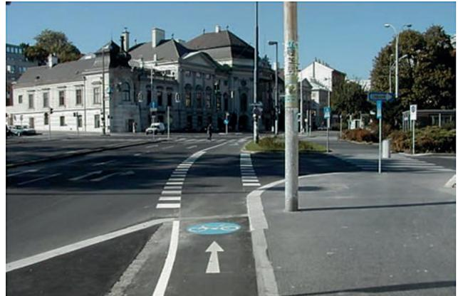
Abbildung 84: Absenkung eines Radweges vor einer Kreuzung und niveaugleiche Führung in eine Radfahrerüberfahrt
