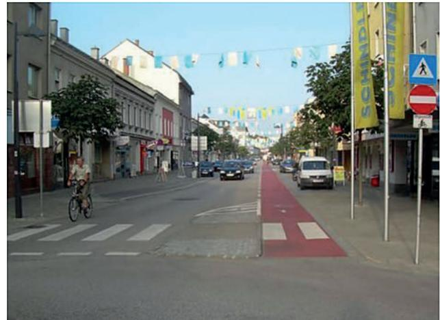
Abbildung 90: Baulich getrennter Beginn eines farblich hervorgehobenen Radfahrstreifens gegen die Einbahn neben Parkstreifen
