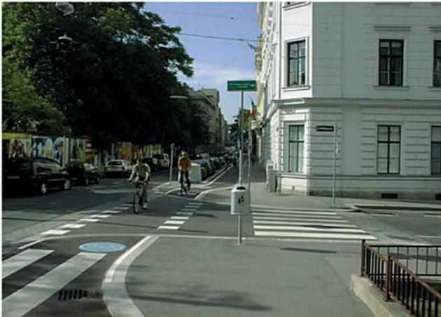
Abbildung 96: Von der Fahrbahn nicht abgesetzte Radfahrerüberfahrt
