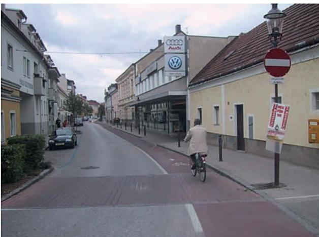
Abbildung 91: Farblich hervorgehobener Radfahrstreifen gegen die Einbahn neben Bordstein
