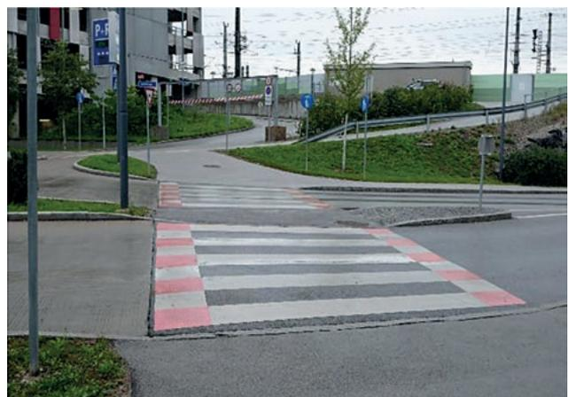
Abbildung 101: Kombinierte Querung eines Geh- und Radweges
