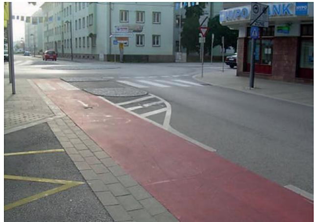
Abbildung 97: Baulich getrennte Führung eines Radfahrstreifens aus einem Kreisverkehr
