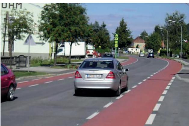
Abbildung 87: Fahrbahn ohne Mittelmarkierung mit farblich hervorgehobenem Mehrzweckstreifen
